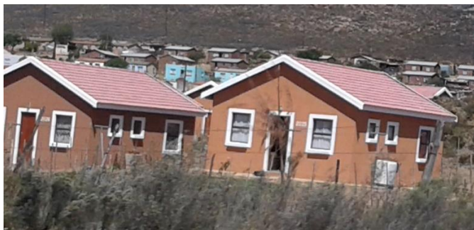
Staatlich geförderter Hausbau als Ersatz für informelle Wohngebiete
